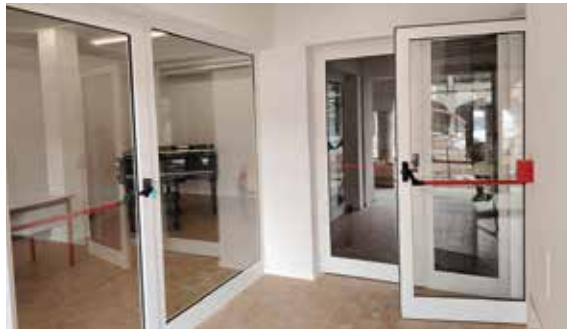
Porte vetrate antipanico, per maggiore sicurezza e migliore separazione acustica degli ambienti
